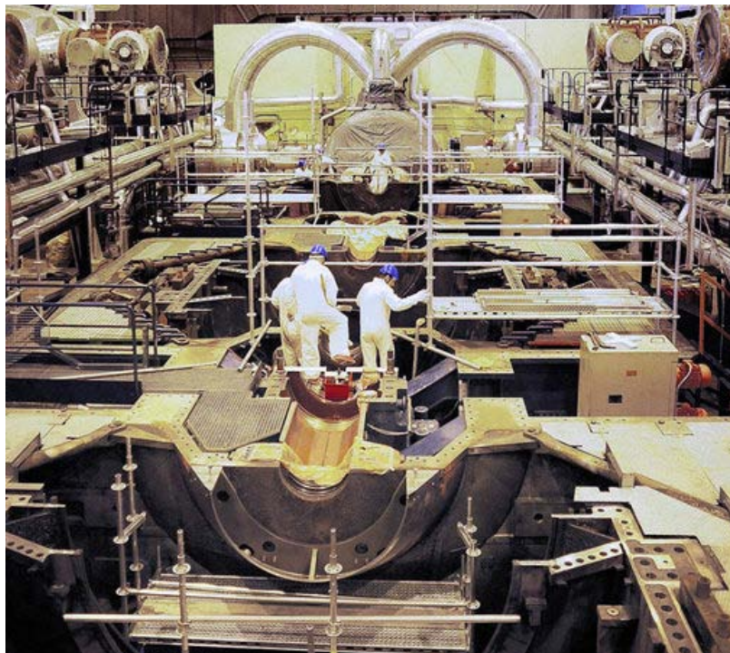
Abbildung 30: Revision in Leibstadt: leeres Gehäuse der Niederdruck-Turbinen 23
