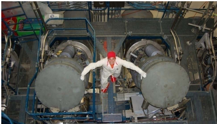
Abbildung 35: Drywell Wasserpumpen Ventil
